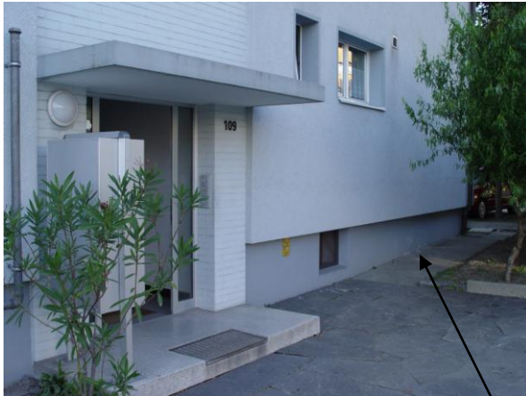
1 - Haupteingang Bernstrasse 109, Zollikofen. Treppenhaus ohne Fahrstuhl. Weg zum Innenhof.
